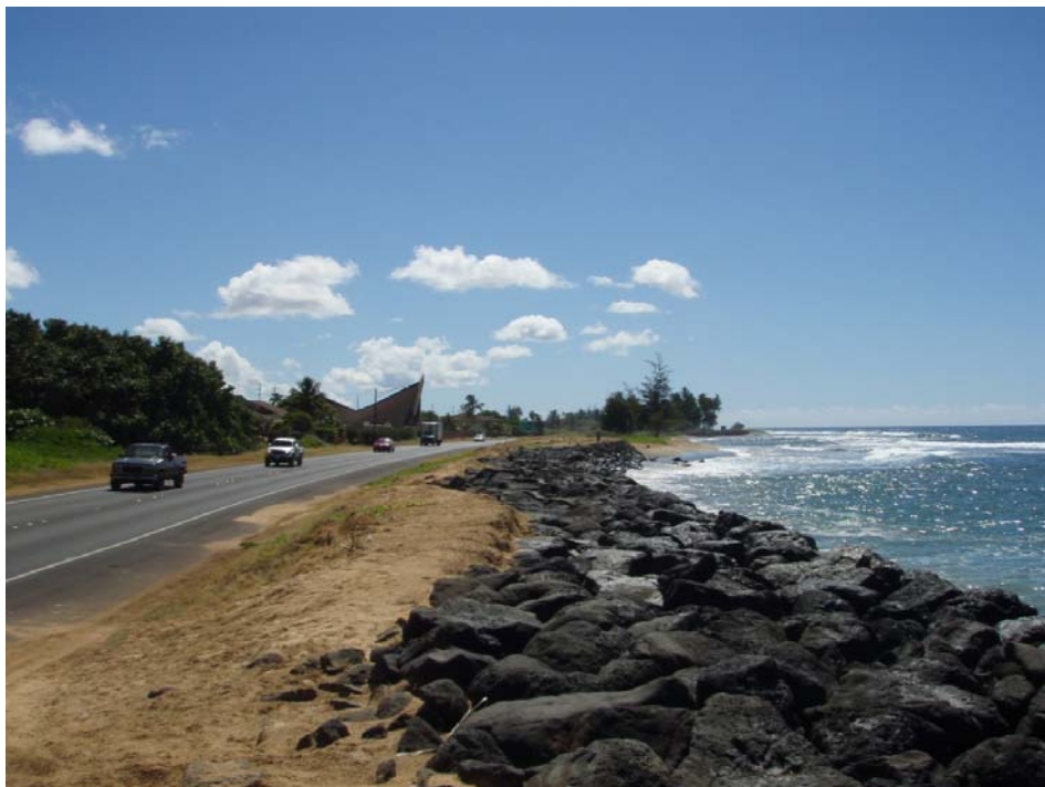
n. Sta. 60+00, Overview
