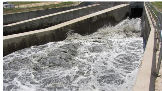
Cherry Creek Outlet Flushing Discharge
